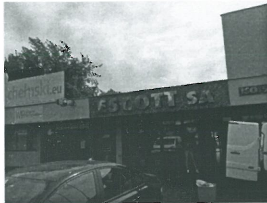
Wejście do budynku biurowego
