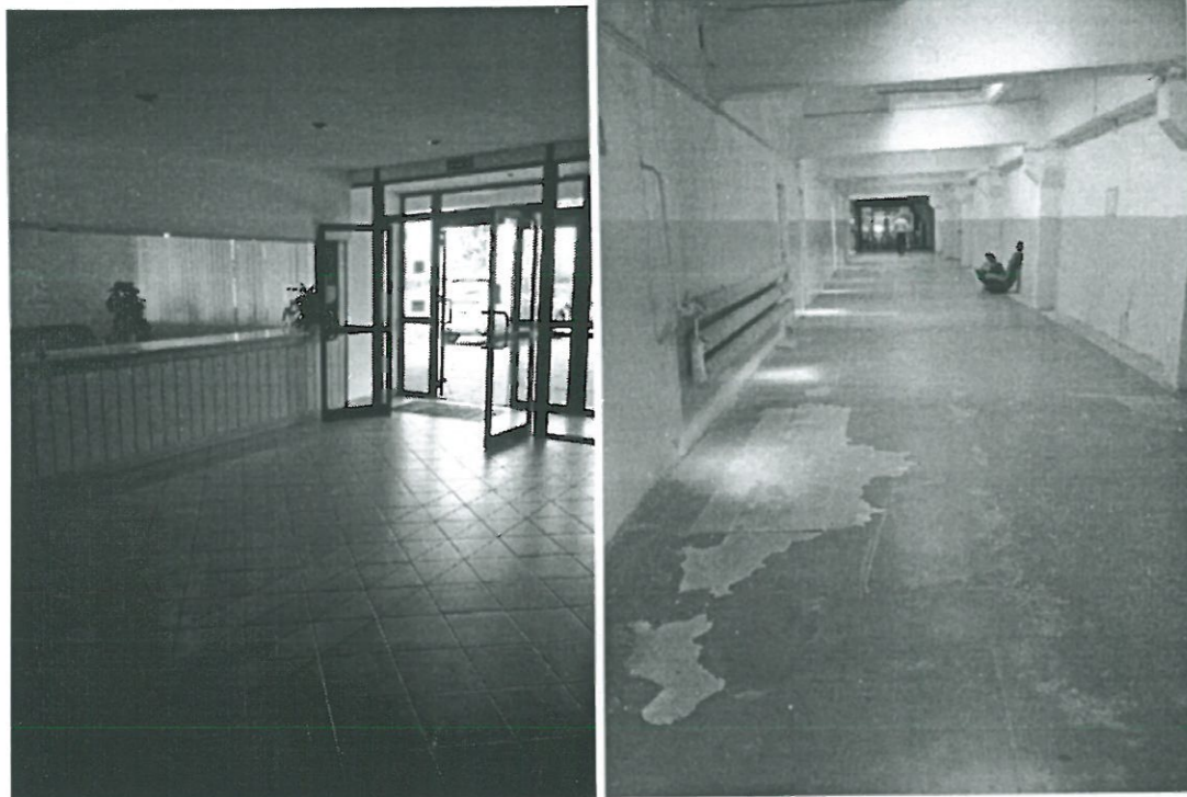
Portiernia budynku administracyjnego Korytarz w budynku produkcyjnym
