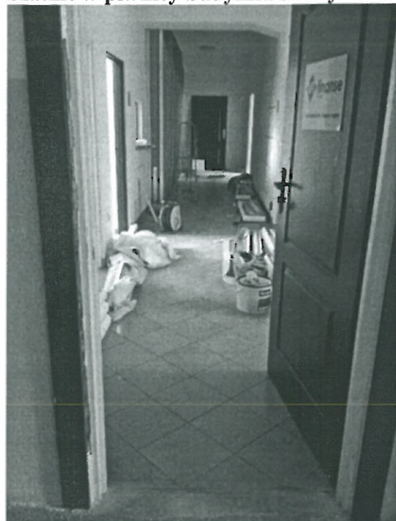
Pomieszczenia w trakcie remontu w budynku szkoły
