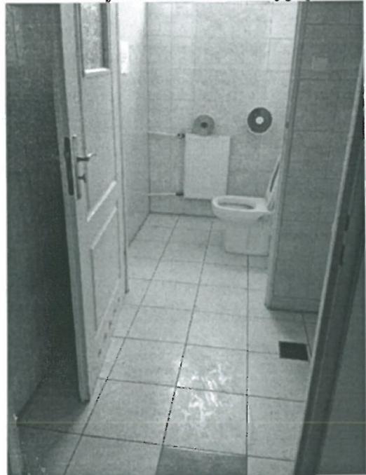
Łazienka w budynku administracyjnym
