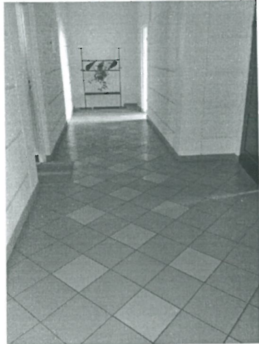
Hol w budynku administracyjnym
